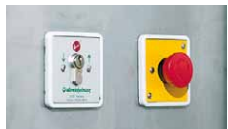
Tür mit Schlüsselschalter und Not-Aus-Schlagtaster
